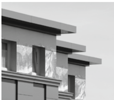
Langfristige Erneuerung und Instandhaltung bei kostengünstiger Modernisierungsmaßnahme mit ALUCOBOND®: die Hörterstraße in Hagen, Deutschland
