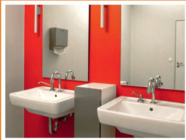
Sanitärbereich: PLEXIGLAS® und DIBOND® Spiegel
