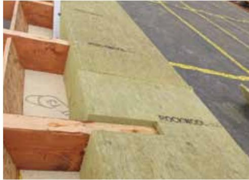
Die Ausklinkungen für die Aufschieblinge müssen exakt ausgeschnitten und anschließend oberseitig gedämmt werden.
