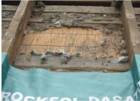
Diese Art der Untergründe erfordert zwingend die Verlegung einer „Schutzschicht“,
