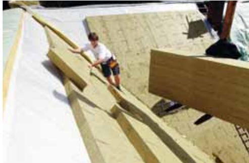
Wärmebrückenfreie zweilagige Verlegung der Masterrock 035 GF für einen hochwertigen Wärmeschutz.
