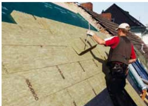
Das Meisterdach Plus lässt sich auch bei gekrümmten Flächen anwenden. Bei diesem Objekt wurde die Masterrock 035 GF im schlanken Sonderformat eingesetzt, damit sie an der Oberfläche dicht anliegt.
