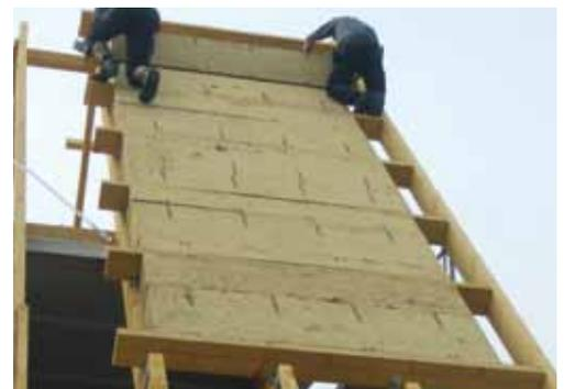
Ausführung eines optisch gelungenen Dachüberstands mit Aufschieblingen und Flugsparren.
