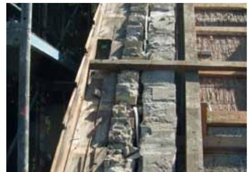
Der luftdichte Anschluss an das zweischalige Mauerwerk im Ortgang muss über einen Fugenglattstrich auf der Hintermauer und anschließendes Aufkleben der Luftdichtungsbahn erfolgen. Alternative Lösung: die schmale Fuge mit Steinwolle dicht ausstopfen, die Bahn bis über die Vormauerschale ziehen und im oberen Bereich mit einer zusätzlichen Anpressleiste sichern, die z. B. durch einen Gesimskasten verdeckt werden kann (s. Bild Seite 13).
