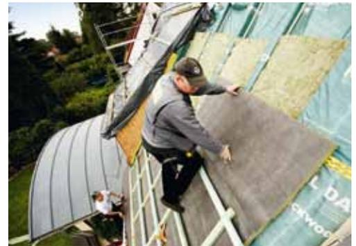
Dann werden Dämmarbeiten nur an Teilflächen eines Dachs ausgeführt, um mögliche Gefahren durch Witterungseinflüsse zu minimieren.
