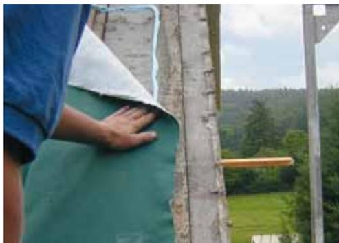
Luftdichter Anschluss der Dampfbremse/ Luftdichtungsbahn an die Giebelmauer (Ortgang) mit einem Dichtkleber aus der Kartusche.
