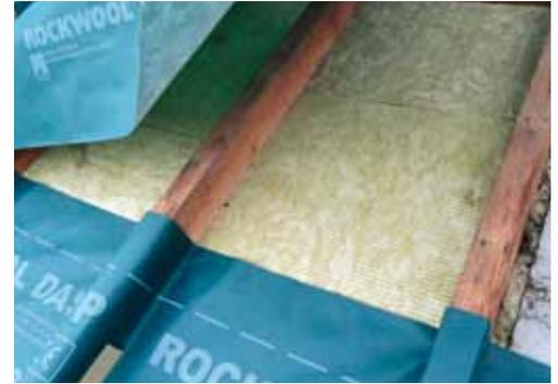
z. B. Floorrock SE, in 20 mm, um eine Perforation der Dampfbremse/Luftdichtungsbahn zu vermeiden.
