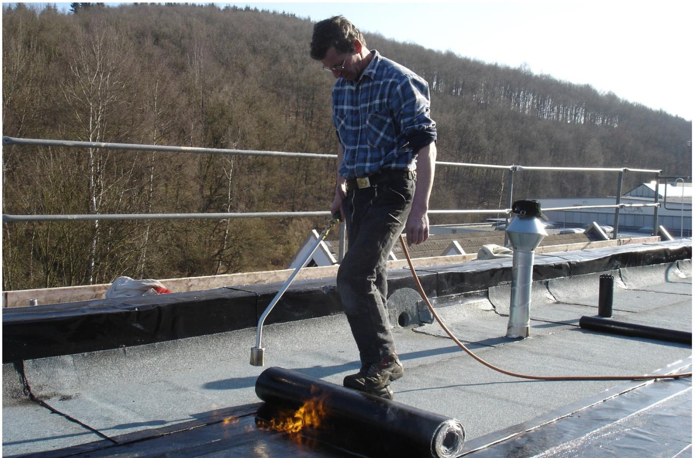
Wussten Sie schon, dass beim Betrieb der üblichen leistungsstarken Propan-Handbrenner mit einem Wert über 85 dB(A) Geräusentwicklung Gehörschutz getragen werden muss.
