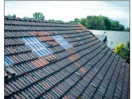
Bild 4: Insgesamt 70 m<sup>2</sup> ausschmelzbare Fläche in Form von FLECK-Lichtpfannen aus Kunststoff wurden auf dem Dach der Ziegelei montiert, um die Anforderungen an den Brandschutz zu erfüllen.
