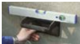
4. Steigeisen ausrichten.
