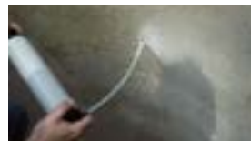
2. Bohrloch reinigen.
