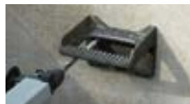
5. Zweites Bohrloch erstellen und reinigen. Steigeisen dient als Bohrschablone.
