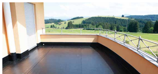
Terrassen- und Balkonabdichtung
