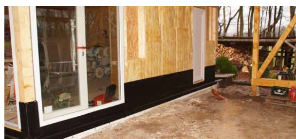
Abdichtung für Bodenplatte und Sockelbereich
