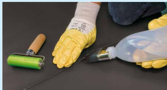
Alternativ können Flächennähte auch mit Quellschweißmittel verschweißt werden: Zwischen die mindestens 4 cm breiten Bahnüberlappungen wird das Witec Quellschweißmittel mit leicht reibenden Bewegungen des Pinsels eingebracht und der Nahtbereich anschließend mit einer Rolle angedrückt.
