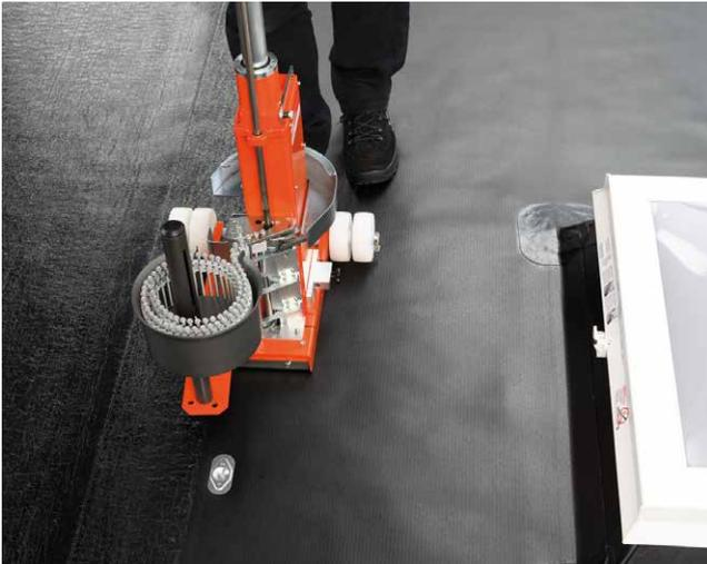
Rationelle Befestigung der Drill-Tec Flachdachbefestiger mit einem professionellen Setzautomaten
