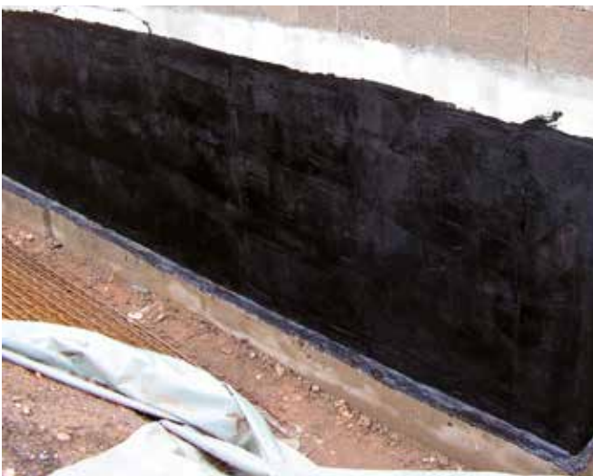
Elastomerbitumen-Voranstrich wird gut deckend aufgebracht
