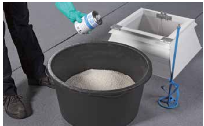
1. Villaperl-Schüttung zusammen mit dem Villaperl-Härter in einen runden 90-Liter-Behälter füllen
