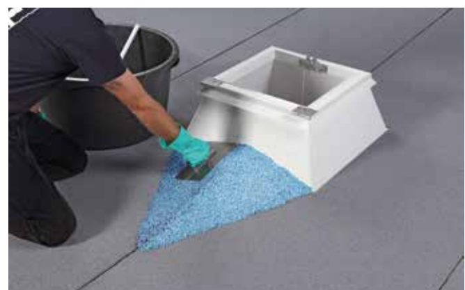
5. Villaperl andrücken und glätten
