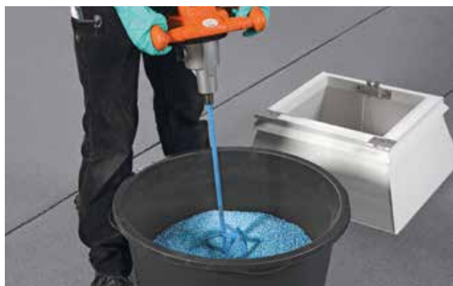
2. Mit einem langsam laufenden Rührwerk gut vermischen, Rührzeit mind. 2 Minuten
