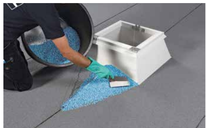
3. Wichtig: Anschließend umtopfen und nochmals mind. 1 Minute mischen, damit die Schüttung gleichmäßig mit dem Härter benetzt wird
