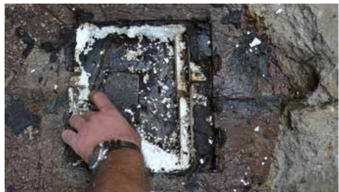
Bestandsaufnahme eines Daches für einen Sanierungsvorschlag
