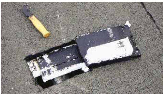
Dachöffnung zur Überprüfung des Schichtenaufbaus
