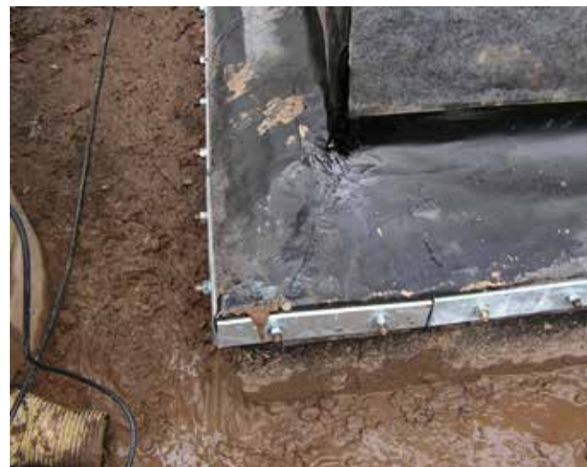
Beispiel eines Los-Festflansches unter Baustellenbedingungen
