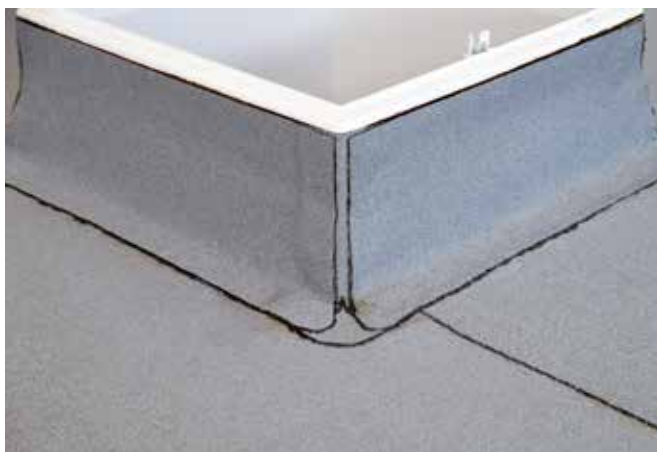
Verarbeitung der Anschlussbahnen
