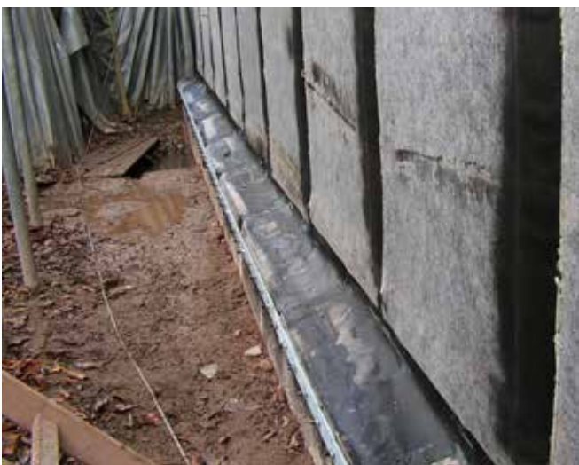
Fertiggestellte Abdichtung an einer Wand
