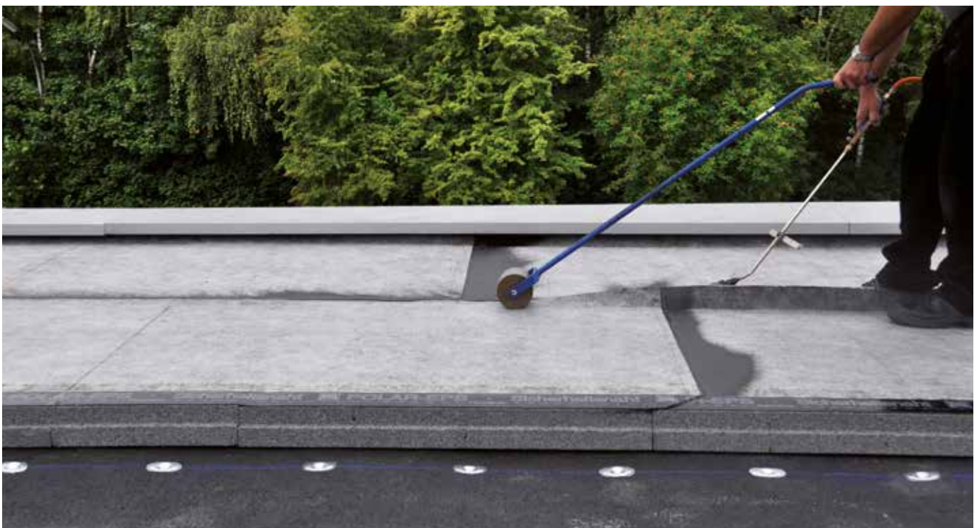
Die Längsnähte der Nahtüberdeckung der Sicherheitsdämmbahn werden nach dem Schließen des selbstklebenden Schutzstreifens mit dem Handbrenner und der Andruckrolle vollflächig verschweißt. Durch den Selbstklebestreifen in der Sicherheitsnaht wird ein Verbrennen des Polystyrol-Hartschaums ausgeschlossen.
