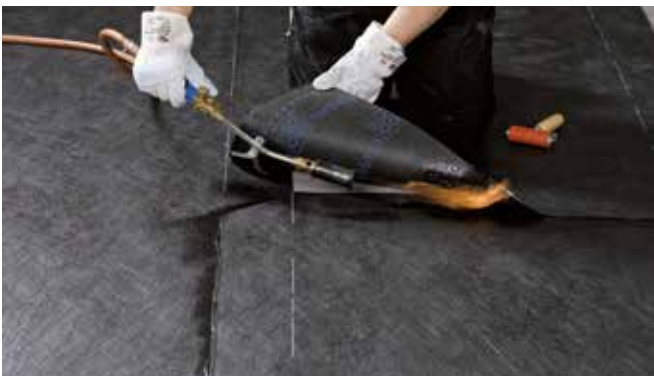
Nähte und Stöße müssen homogen verschweißt werden
