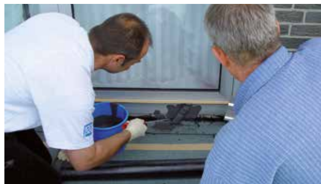
Einweisung an der Baustelle
