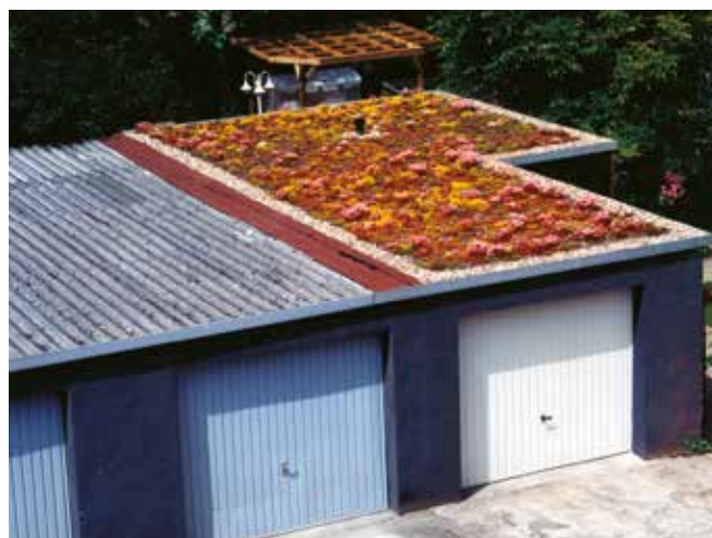
Extensive Dachbegrünung auf einem Garagendach im Gegensatz zur benachbarten Dachfläche
