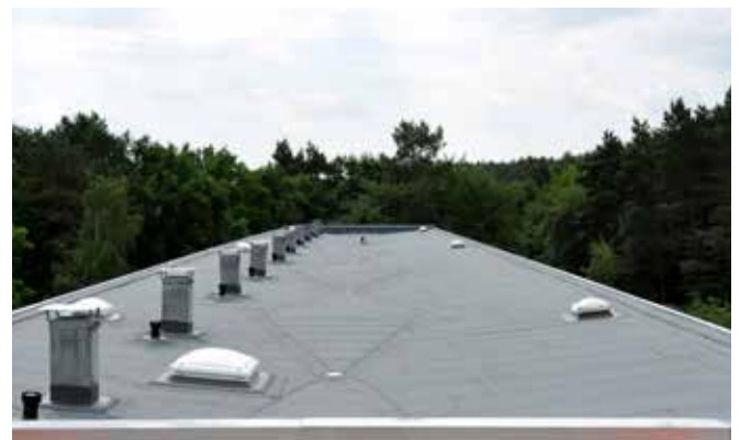
Flachdach mit frei bewitterter Dachabdichtung
