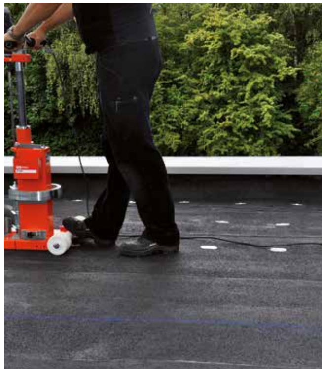
Zunächst wird das vorhandene Dachschichtenpaket mit mechanischen Befestigungselementen fixiert.
