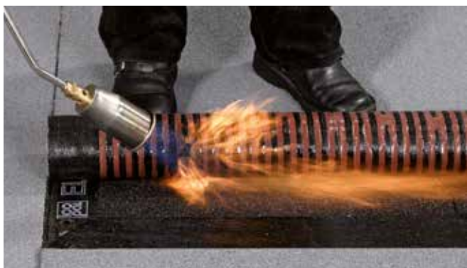
Icopal Bahn mit bestreuungsfreiem Querstoß
