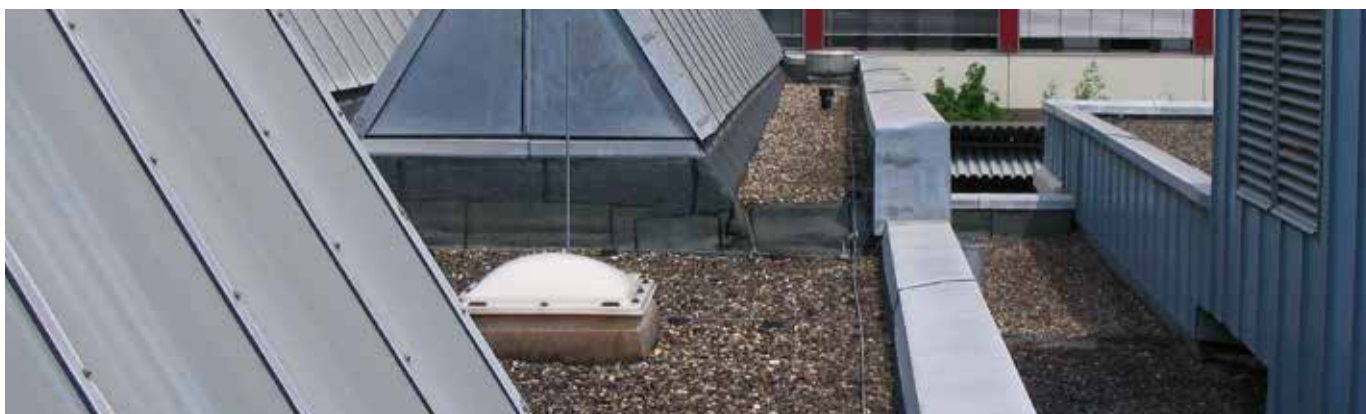
Flachdach mit erschwertem Zugang
