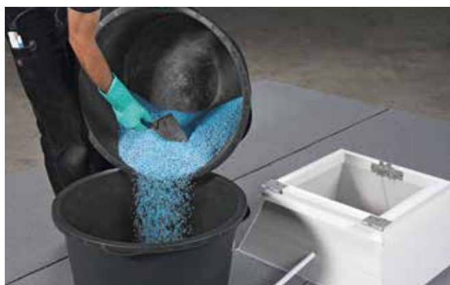
4. Villaperl auf der markierten Fläche verteilen
