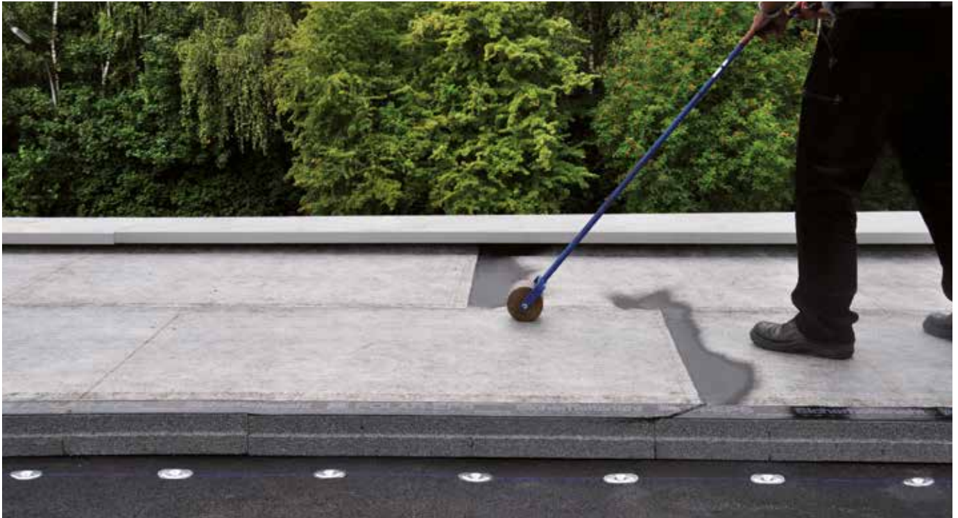
Nachdem die Sicherheitsdämmbahn verlegt ist, kann der Querstoßbereich der ersten Abdichtungslage mit einem Handbrenner geschlossen werden.
