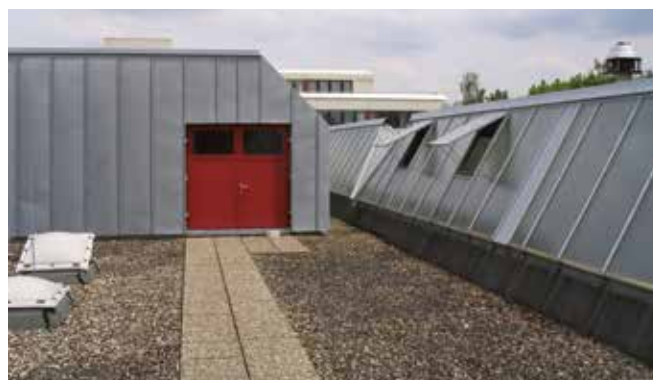
Flachdach mit Auflast
