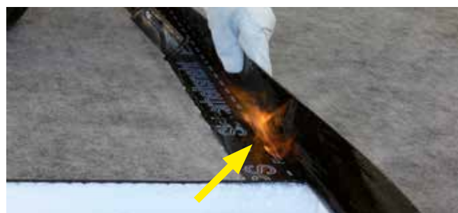
Flammschutz bei der Icopal Sicherheitsdämmbahn
