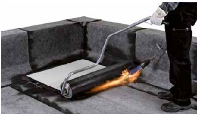
Rollenführungsbügel – für exaktes Führen der Schweißbahn-Rolle und kontrolliertes Arbeiten
