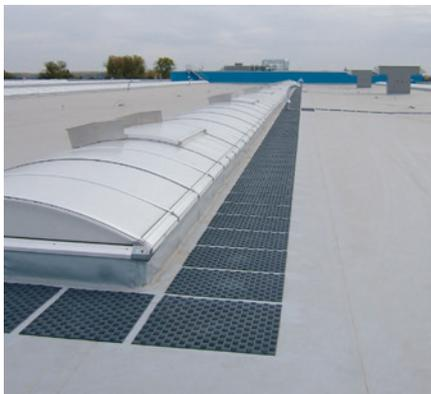
Inspektionswegeplatte eine lastverteilende Wirkung. Eine Verlagerung der Inspektionswegeplatten auch bei erhöhten Windlasten wird durch Heißluftverschweißung mit den EVALASTIC®-Dachbahnen verhindert. Die optisch klare Abgrenzung von Dachbahnen und Inspektionswegeplatten hat einen weiteren Vorteil: Die Wegführung (Inspektions- und Wartungswege) für Personen auf Dächern wird dadurch eindeutig vorgegeben.
