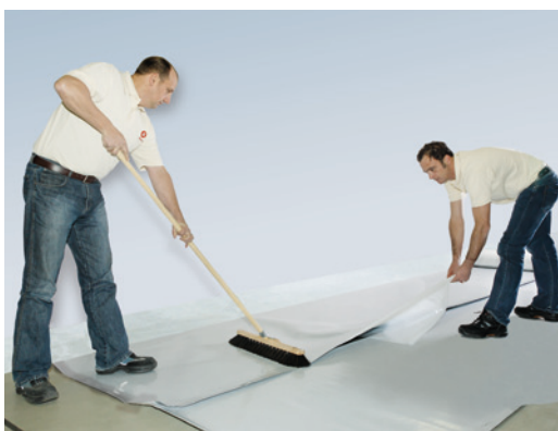
Bild 2: Schutzfolie seitlich herausziehen und Bahn blasenfrei andrücken
