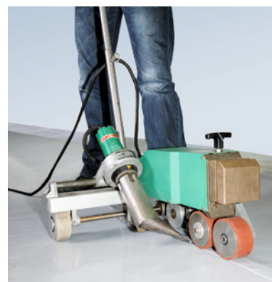
Bild 3: Schweißen mit der Heißluft-Schweißmaschine
