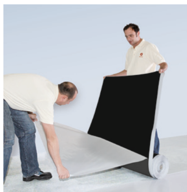
Bild 1: Abziehen der Schutzfolie
