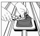
1. DEKTITE® an Rohr anpassen.
