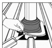
3. Dichtungsmasse auftragen.
