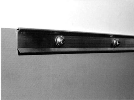
Biegesteifes Klemmprofil zur Fixierung von Wurzelschutz- und Dachabdichtungsbahnen und zur Linienfixierung von schrumpffährdeten Folien.
