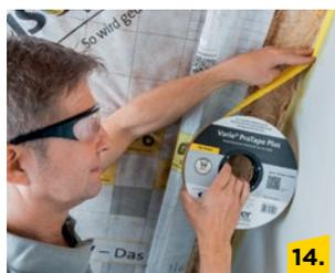
Der Anschluss an angrenzende Bauteile erfolgt über den Dichtstoff von der Rolle Vario® ProTape Plus (hier gezeigt) oder alternativ mit Vario® DoubleFit
