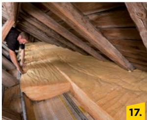
An allen aufgehenden Bauteilen sind die Filze so anzuschneiden, dass keine Hohlräume verbleiben.
