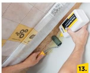
Folie am Giebel zurückschlagen und mit Kreppband fixieren. Mit Pinsel/Schaumwalze den Haftvermittler Vario® MultiPrime auftragen.
