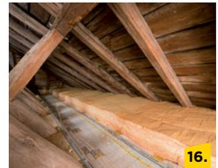
Sobald die Abdichtungsarbeiten fertiggestellt sind, folgt die Dämmung mit Topdec DF 1-035 Reno.
