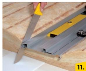
11. Dämmstoff entlang der Führungsschiene zuschneiden.
