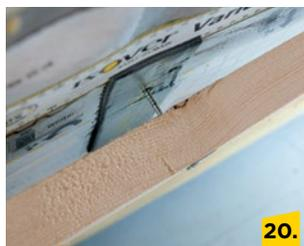
Nur so ist die Durchdringung der Folie luftdicht, da der Anpressdruck der Lattung fehlt.
