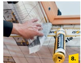
Das an den Fensterseiten fehlende Folienmaterial anfügen. Dazu zwei Folienlappen passgenau zuschneiden (Überstand zum Andichten in der Nut berücksichtigen) und am Sparren antackern.
