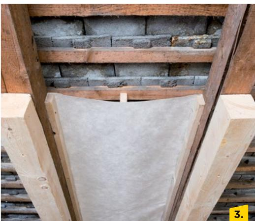
Folienabschnitt über die mittlere Abstandsleiste spannen und mit einer weiteren Dachlatte an der rechten Sparrenseite anschrauben.
