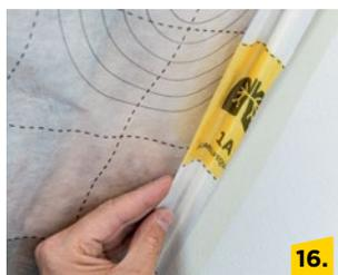
Folienüberhang zu einer Entlastungsschleife falten und Abdeckband des Dichtstoffs abziehen und andrücken. Hier ist im Nachgang eine harte Andruckrolle ein sinnvolles Hilfsmittel.
