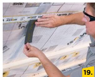
Bei versetzten Sparren die Lattung über Stellschrauben anpassen. Zuvor den Sparrenbereich mit dem Nageldichtband Vario® AntiSpike überkleben.
