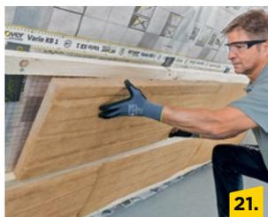
Die Lattenzwischenräume mit einem Untersparren-Klemmfalz z.B. Integra UKF-032 ausdämmen. Anschließend Innenbekleidung montieren.
