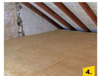
Ausrollen des Dämmfilzes auf der Geschosdecke (bei Holzbalkendecken Ausbildung einer Luftdichtheitsebene prüfen).
