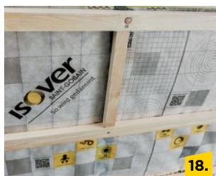
Eine Lattung zur dauerhaften mechanischen Sicherung der Klemmfilze im Gefach ist in jedem Fall notwendig! Bei der Montage der Querlattung ist eine Abstandshilfe sinnvoll.
