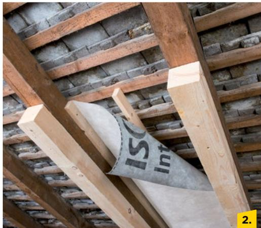
Den Zuschnitt der Unterdeckbahn (Schnittmaß = Sparrenabstand + ca. 12 cm) auf eine handelsübliche Dachlatte tackern. Anschließend Dachlatte mit dem Folienstück an die linke Sparrenseite schrauben.
