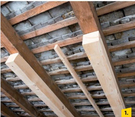
In der Gefachmitte wird eine Abstandsleiste angeschraubt. Außen sind die Aufdopplungen der Sparren zu sehen, die für die Erzeugung einer sinnvollen Dämmdicke notwendig sind.
