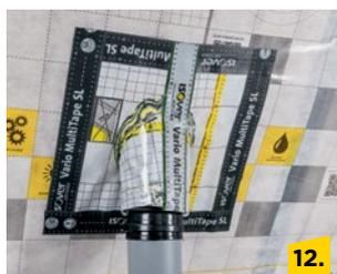
Unvermeidbare Durchdringungen mittels Manschetten abdichten. In jeder Rolle Vario® KM Duplex UV enthält der Einleger eine ausführliche Schritt-für-Schritt-Bauanleitung zur Fertigung von Luftdichtmanschetten.
