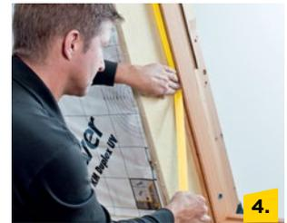
Klimamembran zunächst vollständig über den Fensterausschnitt führen und alle Folienüberlappungen verkleben.
