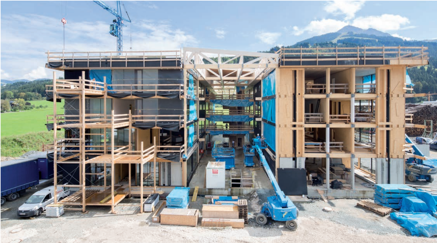
Die Bauphase – In knapp einem Jahr entstand der Gebäudekomplex
