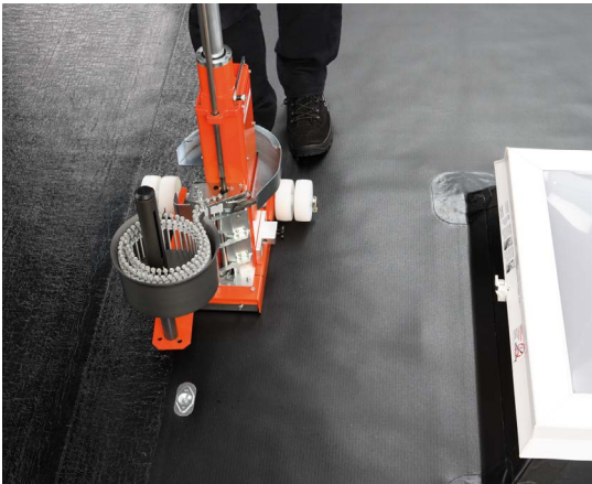
Rationelle Befestigung der Drill-Tec Flachdachbefestiger mit einem professionellen Setzautomaten
