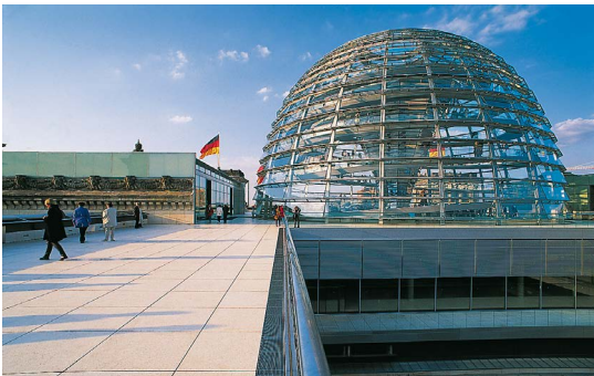
Sicher abgedichtet mit dem Wolfin PYE-System: Das Dach des Reichstags in Berlin.
