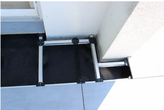
Auch komplizierte Ecken lassen sich mit Hilfe der Verbinder lösen. Dabei sollte der Abstand von der Schiene zur Wand nicht weniger als 30 mm bzw. 60 mm mit Randhalter betragen.
