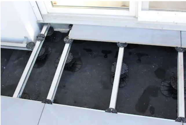
Um einen stabilen Türaustritt bilden zu können, wird die Schiene senkrecht (mindestens eine Plattenbreite) zum Austritt verlegt.
