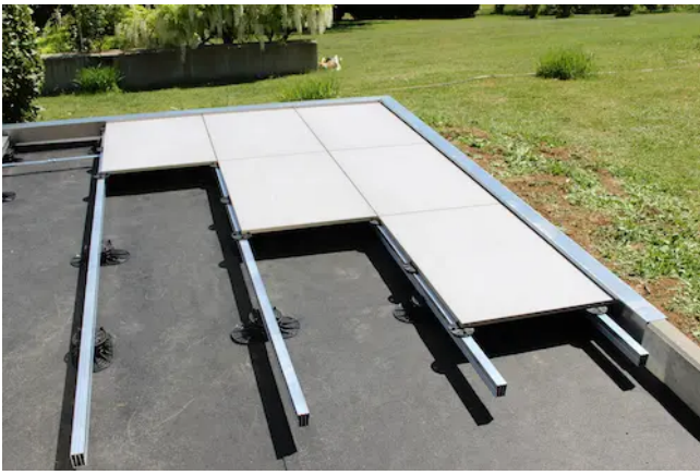
Mehrere Auflagepunkte bei Feinsteinzeug Terrassenplatten oder einem Läuferverband mit geringer Anzahl an Stelzlager möglich.
