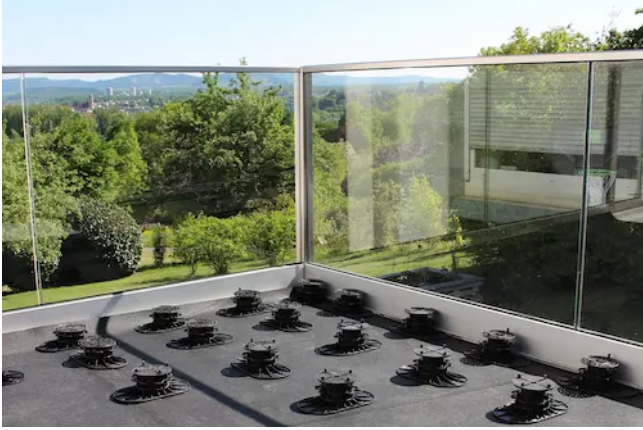
Vor dem Auslegen der Elefeet® Stelzlager die Höhe grob voreinstellen.
