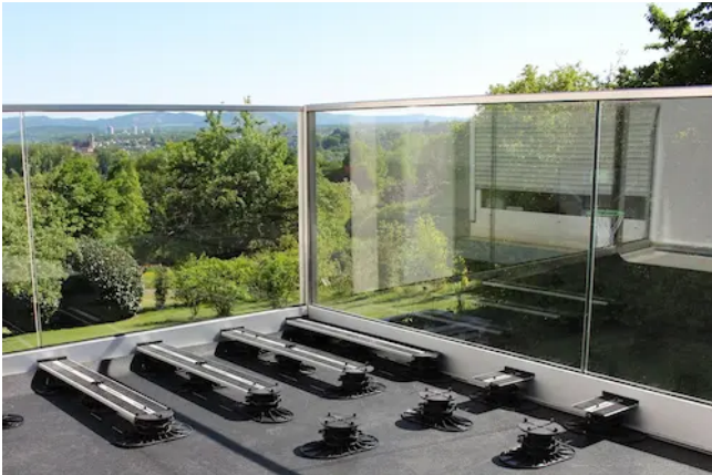
Zubehörteile je nach Randsituation einbauen.
