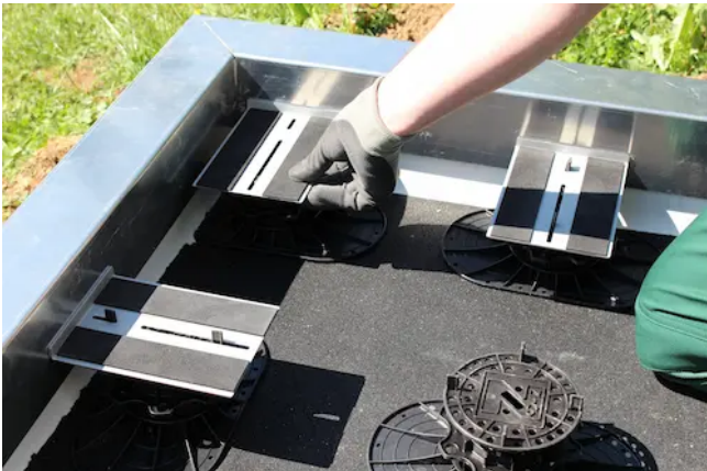
Randhalter bei ganzen Platten oder Zuschnitten > 250 mm verwenden.
